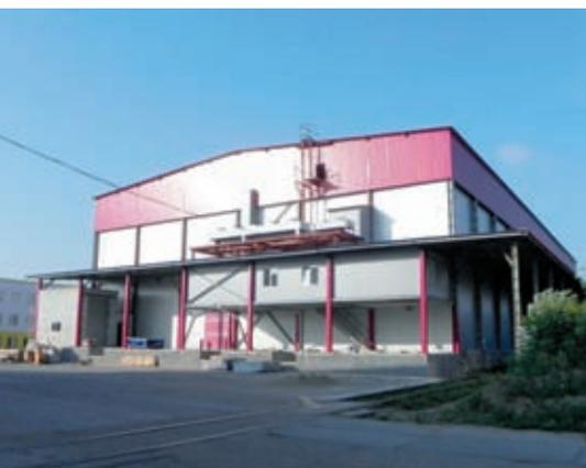
Склад состоит из трех объемов общей площадью 2500 м<sup>2</sup> (1 камера 1300 м<sup>2</sup>, 2 камеры по 600 м<sup>2</sup>) высота камер 12 м. Теплоизолирующий контур выполнен из ППУ сэндвич-панелей толщиной 150 мм.
