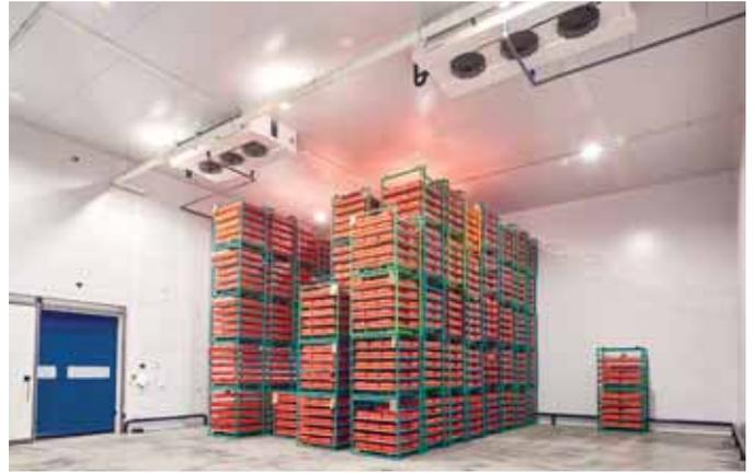
дители Guentner в специальном исполнении: их корпуса изготовлены из нержавеющей стали, вместо медных трубок в теплообменном блоке также применены трубки из нержавеющей стали, а ламели теплообменного блока имеют эпоксидное покрытие.
