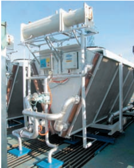
Рис. 1. Специальный четырех-контурный охладитель жидкости
