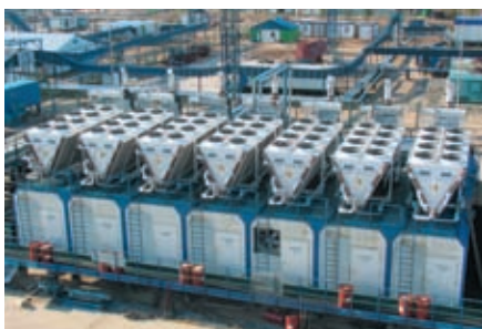
Рис. 2. Система охлаждения газопоршневых энергоустановок
