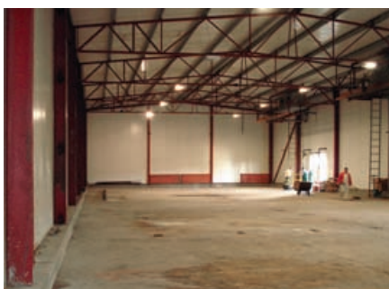
Рис 1. Склад «Меркурий Айс» до реконструкции.
