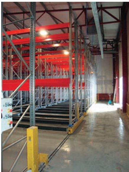
Рис 2. Склад «Меркурий Айс» после реконструкции.
