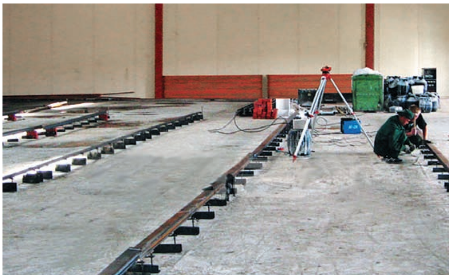
Рис 3. Укладка рельсовых направляющих.
