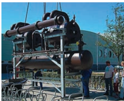
Установка испарительно-конденсаторного блока каскадной холодильной системы NH 3 /CO 2 в машинное отделение
