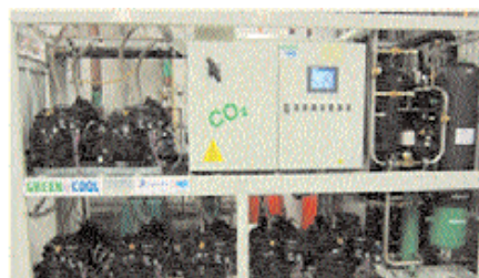
Рис. 5. Компрессорный агрегат на базе компрессоров для сверхкритических циклов CO 2
