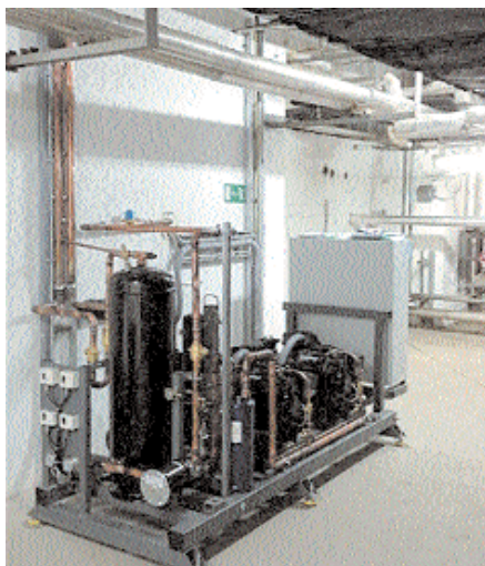
Рис. 3. Агрегат на базе двух компрессоров Stream 4MA-22X
