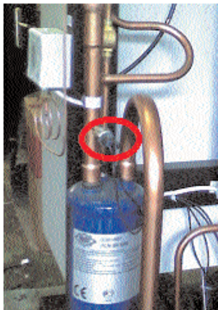
Пример установки реле давления PS4 на холодильном агрегате.
