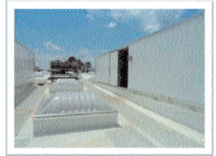
WALMART Джорж-Таун, США. Установлены холодильные машины HEATCRAFT на фреоне для кондиционирования и среднего холода, CO 2 на низкий.
