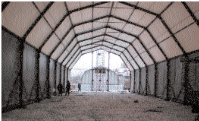
Полигональная арка из сортового металлопроката
