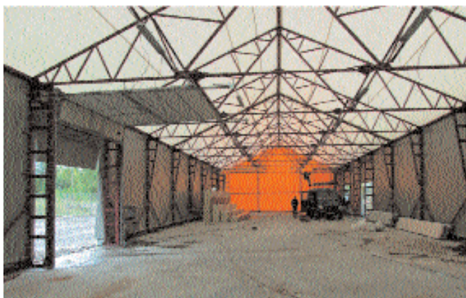
Двускатная стропильная ферма с затяжкой
