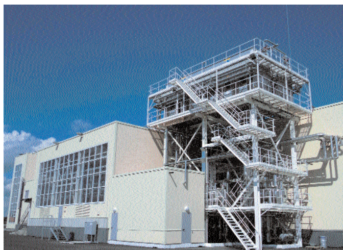
Рис. 2 Аммиачное машинное отделение и конденсаторная площадка
