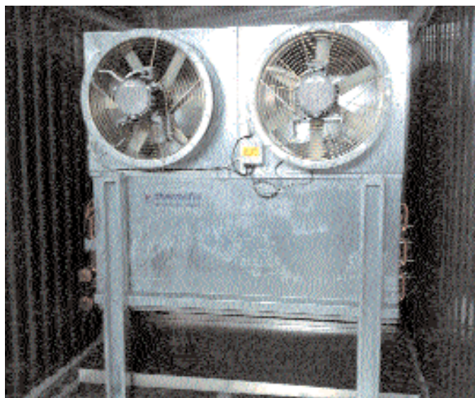
рис.6. Внешний вид испарителя шоковой заморозки (турбофриза), установленного в одной из контейнерных скороморозильных установок
