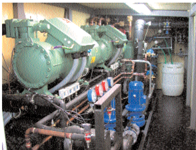
рис.8. Компоночный чертеж мобильной контейнерной установки для ледового поля и вид компрессорного агрегата внутри контейнера
