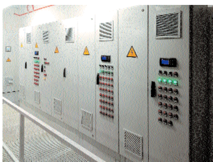
Рис. 4. Система управления транскритической установкой Metro, Солнцево
