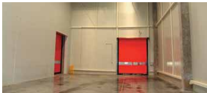
Мягкие скоростные ворота с внутренней стороны холодильной камеры
