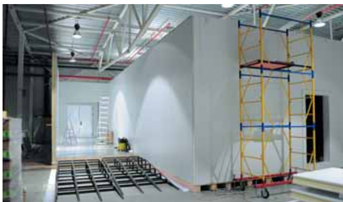
Монтаж низкотемпературной камеры (-55°C) с загрузочно-разгрузочным тамбуром и вентилируемым подпольем
