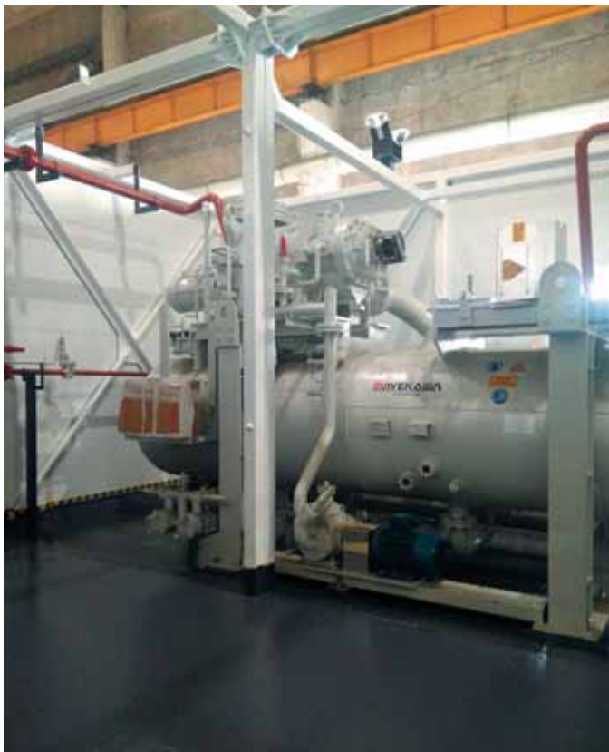
Установка компрессорного агрегата Musom F280JM-VE внутри сборно-разборного мобильного контейнера
