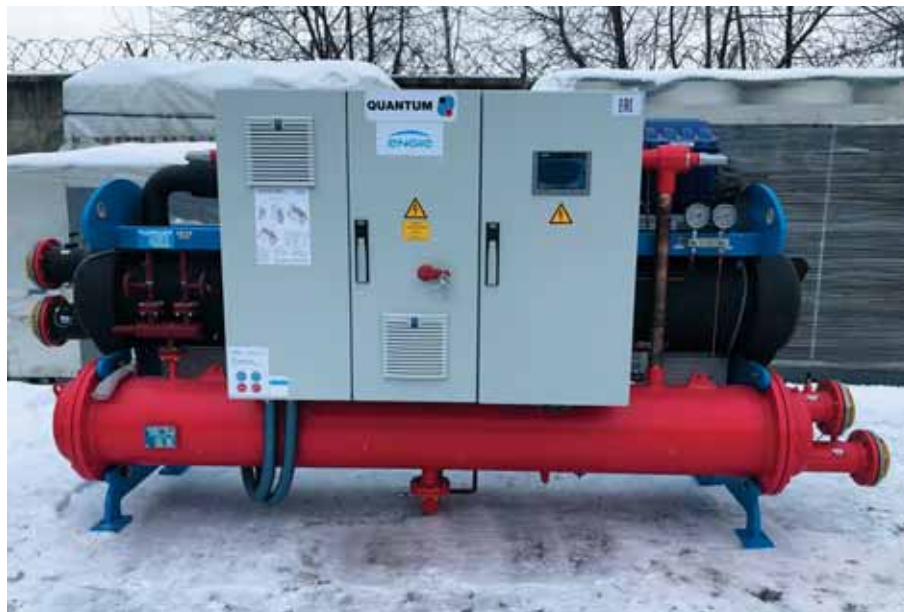
Чиллер Engie Quantum X060-P2C-LH на базе компрессоров Danfoss Turbocor
