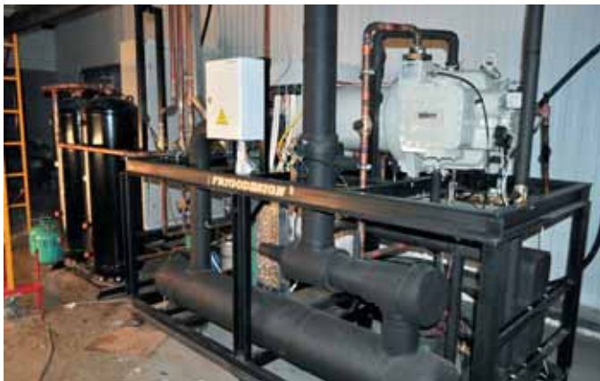
Монтаж компрессорной установки на «ОкеанПремиум»
