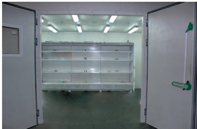
Холодильная витрина в климатической испытательной камере
