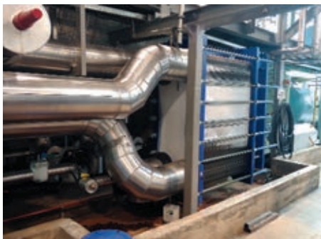
Резервный теплообменник-испаритель после завершения монтажных работ
