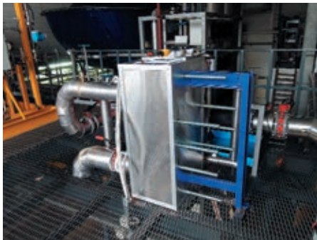
Пластинчатый теплообменник-газификатор углекислоты с центробежным насосом подачи хладоносителя
