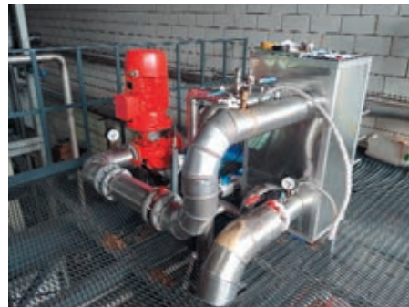
Пластинчатый теплообменник-газификатор углекислоты с центробежным насосом подачи хладоносителя
