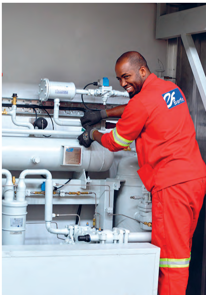
Рис. 7. Сальниковый винтовой компрессорный агрегат производства ЮАР
