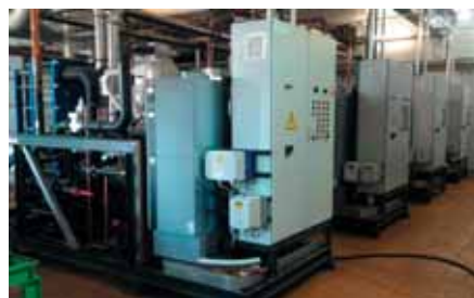
Четыре установки ледяной воды в проточных пластинчатых испарителях
