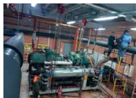
Замена технологических трубопроводов
