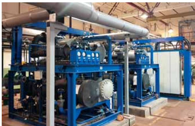
БХУ600-2В-2КК-ЗИК-R134a-U4 ( Q_0=1306 кВт, N_{\text{потреб}}=255.2 кВт)
