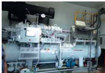
Холодильный агрегат туннеля закалки мороженого
