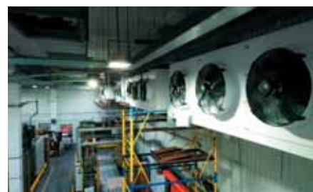
Воздухоохладители на складе хранения готовой продукции
