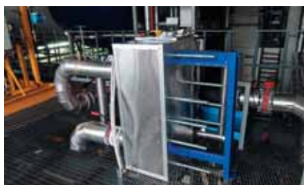
Промежуточный теплообменник и насосный агрегат ФРИГОДИЗАЙН® системы фрикулинга
