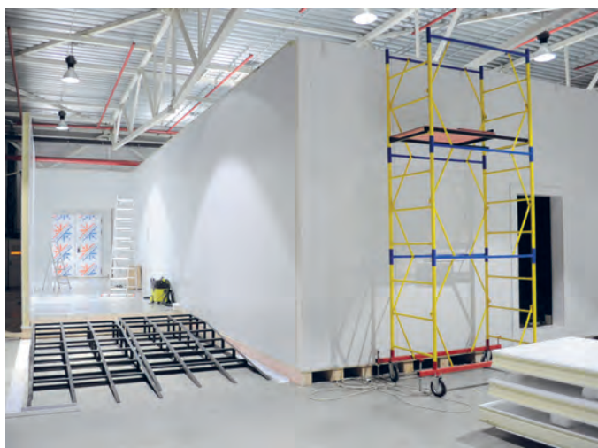
Низкотемпературный комплекс для хранения биопрепаратов (-55°C) с вентилируемым подпольем
