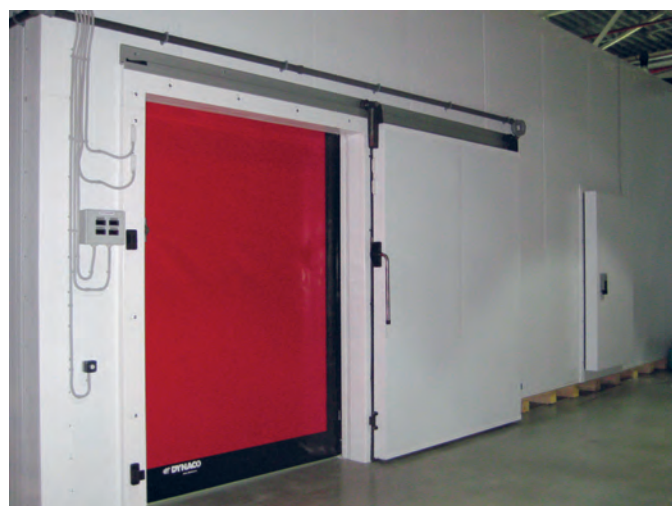
Низкотемпературный комплекс для хранения биопрепаратов (-55°C) с вентилируемым подпольем
