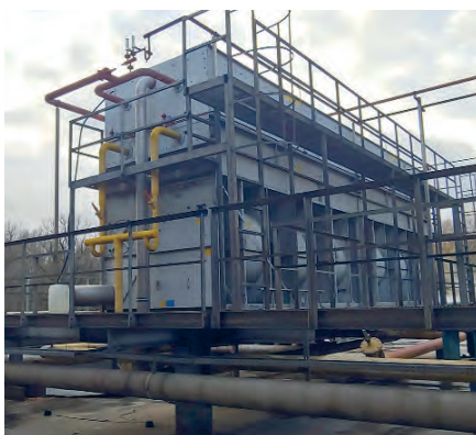
Аммиачный конденсатор испарительного типа Baltimore Aircool
