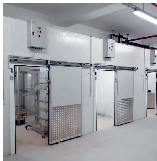
Низкотемпературная холодильная камера
