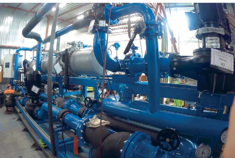
Холодильная машина перед установкой в контейнер
