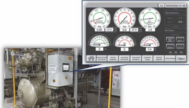
Замена панели управления на компрессорном агрегате Mayekawa (Musot)
