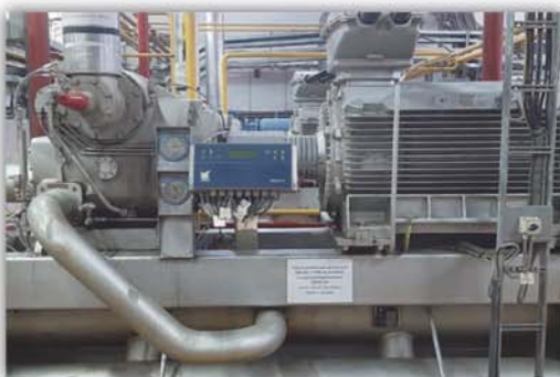
Замена системы управления Unisab II на компрессорном агрегате Sabroe
