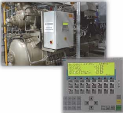
Замена панели управления на компрессорном агрегате Mayekawa (Musot)
