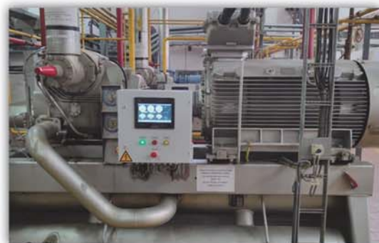
Замена системы управления Unisab II на компрессорном агрегате Sabroe
