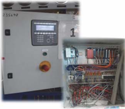
Комплексная модернизация системы управления холодильного агрегата с двумя компрессорами Howden
