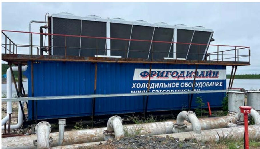
Холодильная установка после подключения к трубопроводам захлаживания дамбы
