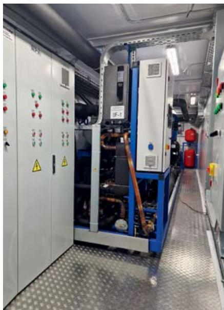
Размещение электрических шкафов управления внутри контейнера
