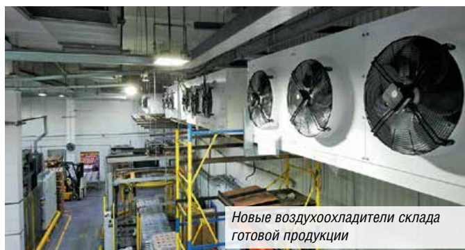
Замена кожухотрубных испарителей
